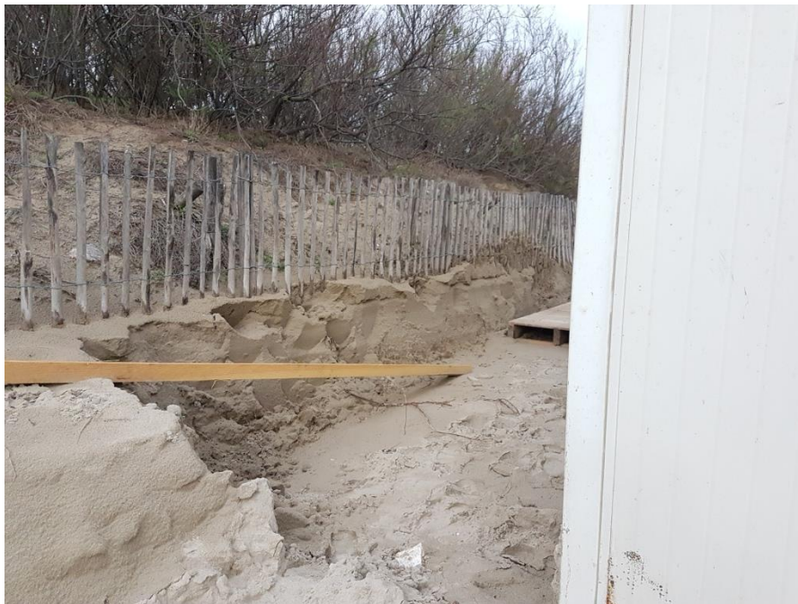
Figure 1 : Décaissement et mise en péril de la pérennité de la dune, de la dynamique de l'écosystème et, par rebond, mise en péril du massif et l'équilibre dune-plage (photo personnelle, 2017)
