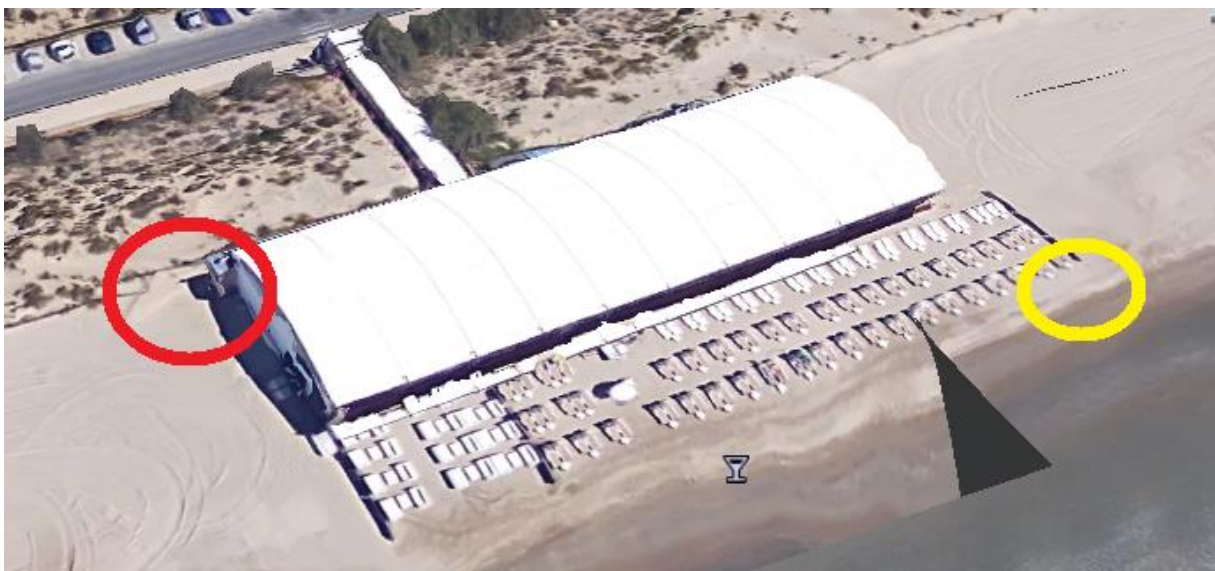
Figure 4 : “La voile Bleue”, située sur la plage de la Grande Motte (secteur 2). Le cercle rouge illustre le faible espace réservé entre la construction pour exploitation et le massif dunaire ainsi que, très clairement un déplacement de sable inapproprié. Le cercle jaune nous permet de constater ici le très faible espace entre l’emprise au sol et le bord de l’eau qui semblerait devoir ici être inférieur au 20 m proposé dans le règlement de la concession (source GoogleEarth©)
